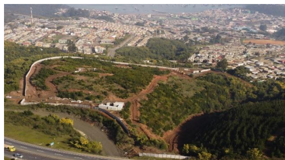
Cierro Perimetral con pandereta. Hospital de Lota
