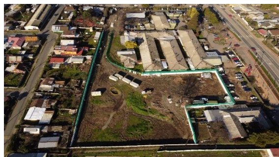
Cerramiento Perimetral. Hospital de Nacimiento
